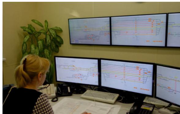
ООО «УГМК-Холдинг», железнодорожная инфраструктура ОАО «СУМЗ». Для увеличения пропускной способности станции, расположенной на расстоянии более 8 км, с помощью ББК-02 организовано удаленное управление и контроль по ВОЛС ЭССО-М, стрелочными приводами и светофорами. Аппаратура систем ЭССО-М и ББК-02 размещена в релейных шкафах в непосредственной близости от объектов управления.
