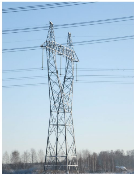
Металлоконструкции опор ЛЭП 35-750 кВ , в том числе опор новой унификации 220-500 кВ
