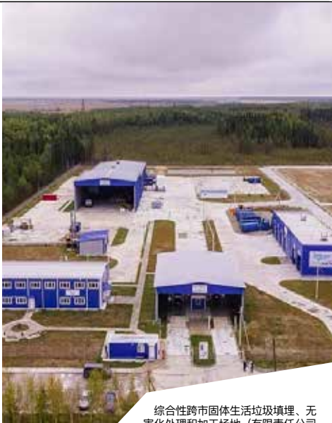
综合性跨市固体生活垃圾填埋、无害化处理和加工场地（有限责任公司“Sitimatik–尤格拉”）
